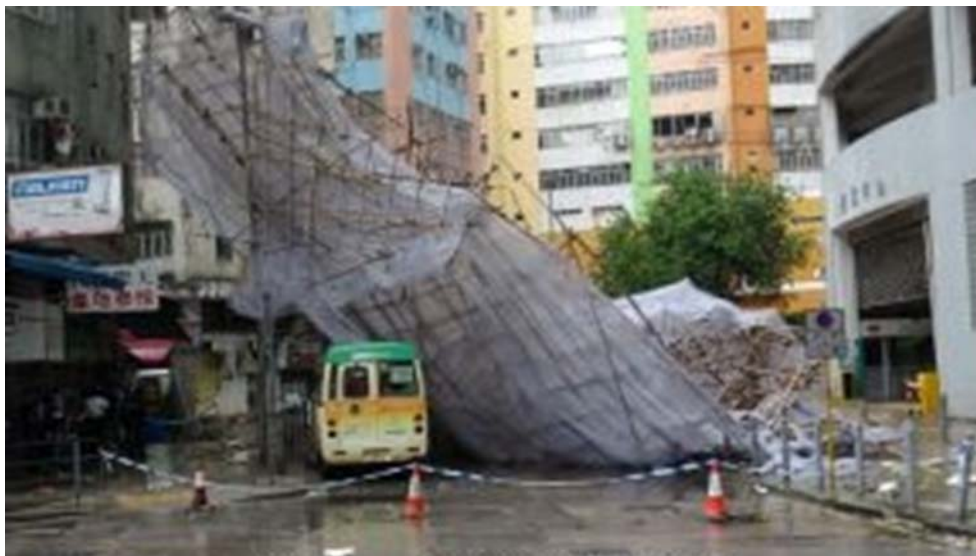
圖 2.3.8 颶風海鷗吹襲期間，葵涌打磚坪街有一幅棚架倒塌，導致一輛貨車及一輛小巴損毀 (相片由星島日報提供)。
