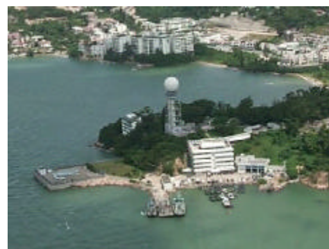
Terminal Doppler Weather Radar at Tai Lam Chung 位於大欖涌的機場多普勒天氣雷達
