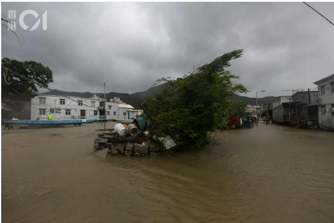
圖 2.2.20 受樺加沙引致的風暴潮影響，大澳水位明顯上升，造成水浸。(鳴謝：香港01 / 梁鵬威攝)
