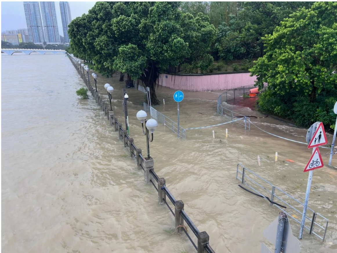
圖 2.2.23 受樺加沙引致的風暴潮影響，沙田城門河水位明顯上升，附近行人路、單車徑及隧道出現水浸。(鳴謝：梁金成)
