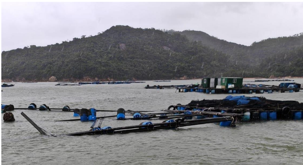
圖 2.2.37 樺加沙襲港期間，大嶼山長沙灣有魚排設施遭風浪影響而受損。(鳴謝：漁農自然護理署)
