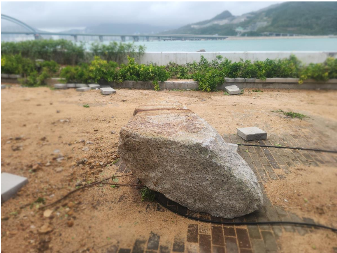
圖 2.2.29 樺加沙襲港期間，將軍澳南海濱長廊有大浪拍岸，有防波堤大石被大浪沖上岸。(鳴謝：有線新聞(上)及 Andes Lau (下))
