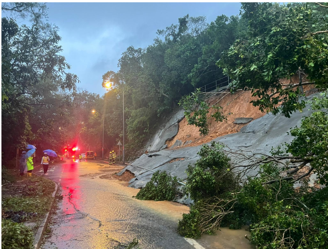
圖 2.2.34 樺加沙襲港期間，大埔新娘潭路出現山泥傾瀉。(鳴謝：土力工程處)
