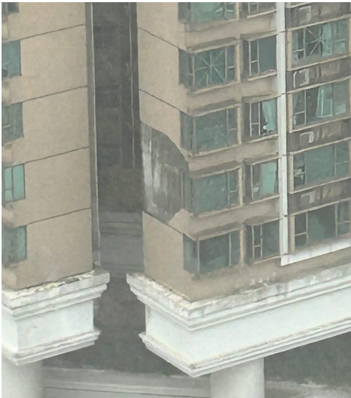
圖 2.2.18 樺加沙襲港期間，深井有住宅大廈外牆牆磚剝落。(鳴謝：CY)
