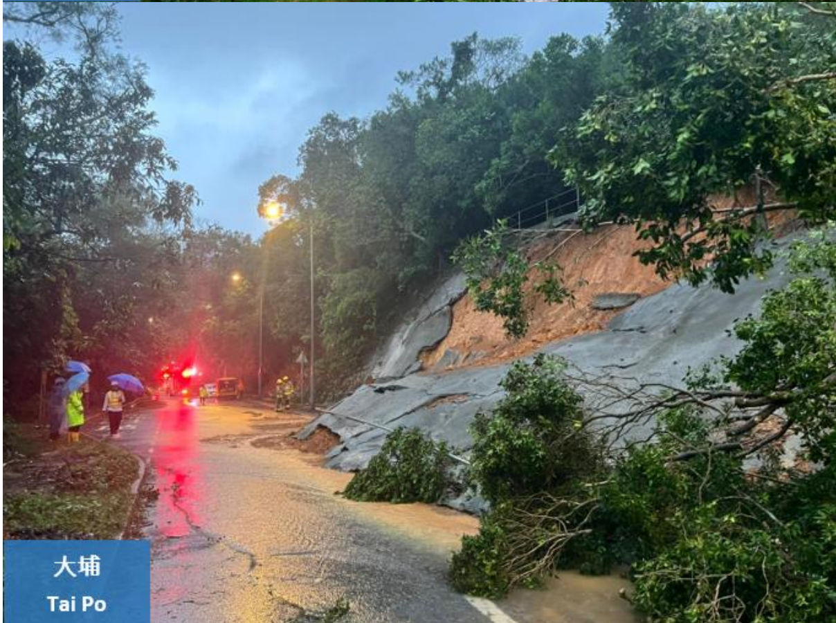
圖 5.14 - 5.17 超強颱風樺加沙襲港對香港多處造成破壞，包括塌樹、越堤浪、風暴潮及山泥傾瀉 (鳴謝：路政署、Kwok Yung Chan/社區天氣觀測計劃、YW Lee、土力工程處處長及土木工程拓展署 署長 (由上至下))
