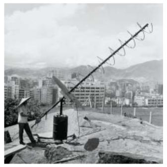
Fig. 4.30 Observatory staff manually aligning an aerial to receive images from a US weather satellite, at a home-made tracker station. (1965). Courtesy Hong Kong SAR Public Records Office 圖 4.30 天文台使用人手調校天線接收美國天 氣衛星的影像 (1965年)。香港特別行政區歷史 檔案館館藏
